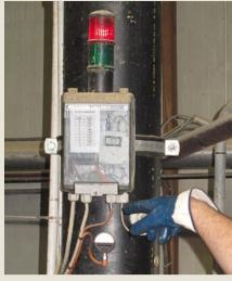
In einer Halle einer Biogasanlage hängt dieses Gaswarngerät. Es schlägt bei Überschreitung der Grenzwerte Alarm.
