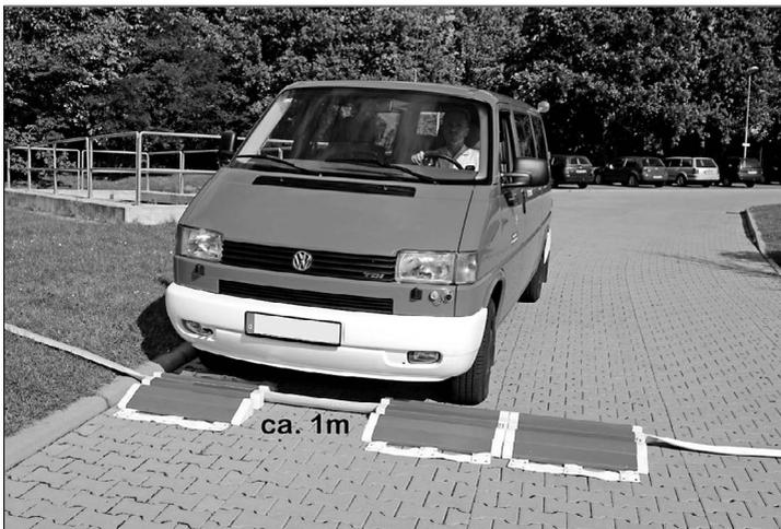
Beim Überqueren von Straßen mit Schlauchleitungen sind mindestens zwei, besser drei Schlauchbrücken auf einer Fahrbahnseite so auszulegen, dass Fahrzeuge verschiedener Spurbreite (PKW/LKW) die Leitung überfahren können. Auf Verkehrssicherung ist besonders zu achten.
