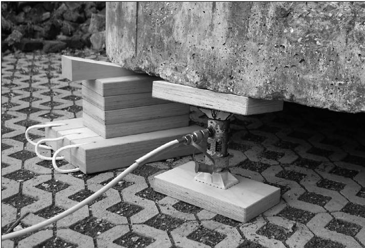
Die Stempel der Hydraulikzylinder können mit Verlängerungsrohren verlängert werden. Die maximale Länge nach Angaben des Herstellers ist zu beachten.
