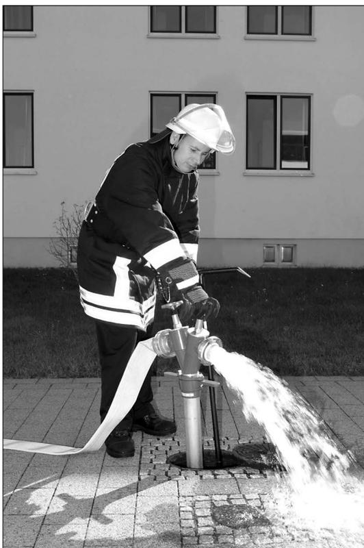
Ein Abgang am Standrohr wird geöffnet.
