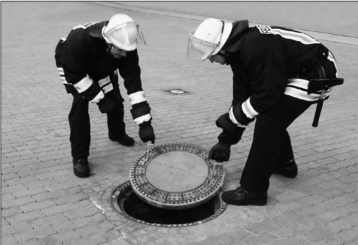
Der Schachtdeckel ist mit Hilfe der Schachthaken einseitig anzuheben und nach hinten wegzuziehen.
