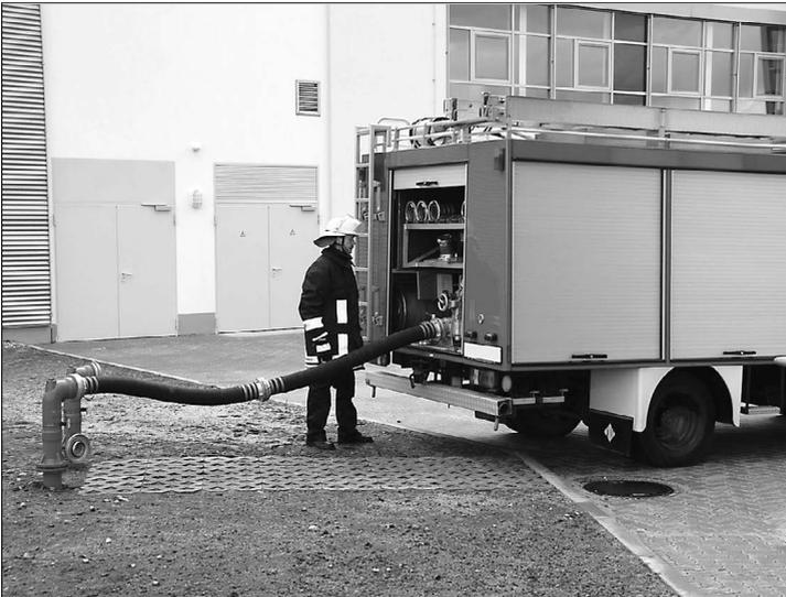
Die Entnahme aus einem Löschwasser-Sauganschluss bei Löschwasserbrunnen, -behältern und -teichen erfolgt unter Verwendung von Saugschläuchen.
